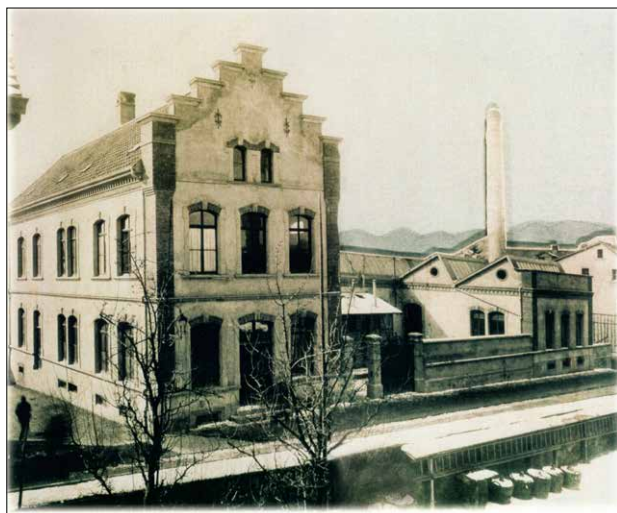
Erstes Fabrikgebäude von 1898 mit Anbauten bis 1902
